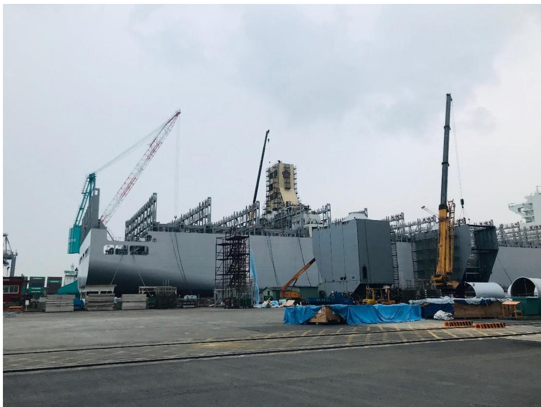
CSBC OOCL 東方星洲輪加裝 scrubber 施工進行
